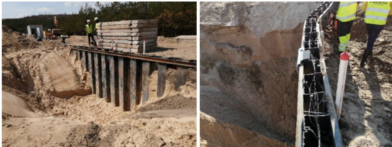
Zdjęcia z testów terenowych ściany oporowej utworzonej z grodzic ze zintegrowanymi czujnikami światłowodowymi.
